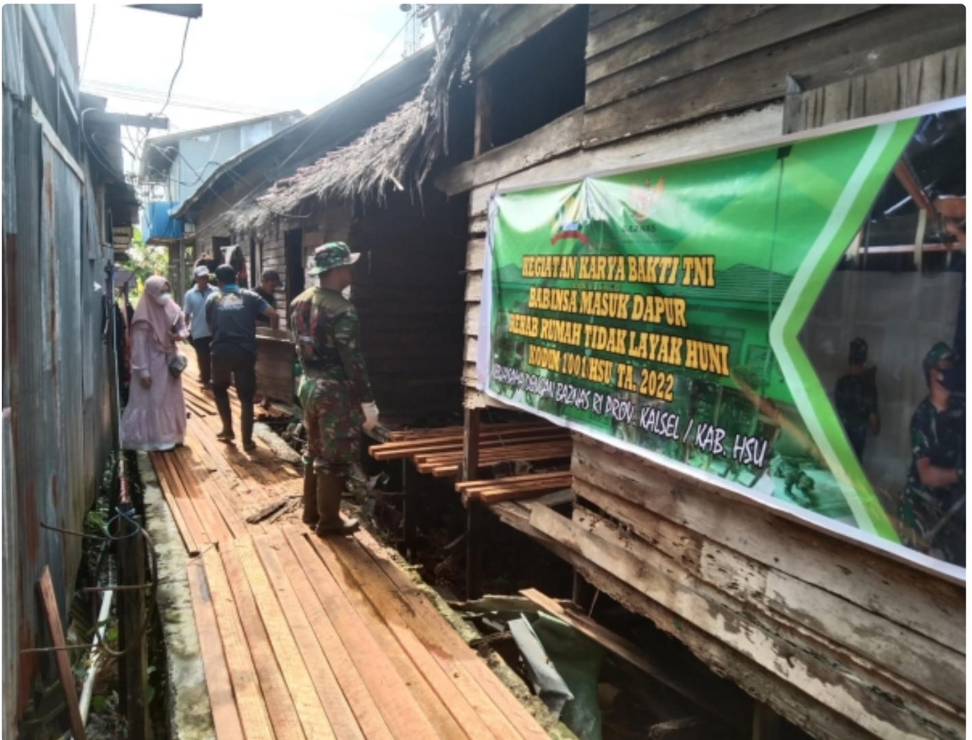
Kodim 1001/HSU-Balangan Bekerja Sama Dengan Baznas Rehab 10 Rumah Di Kab. HSU
